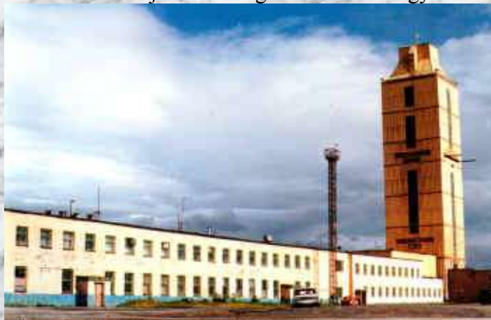
1.3 ábra. A 64-méteres fúróberendezés a 12 km mély Kola-fúrás fölött. 10
